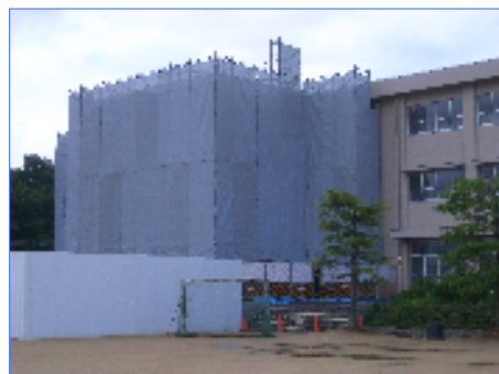
工事中的様子
