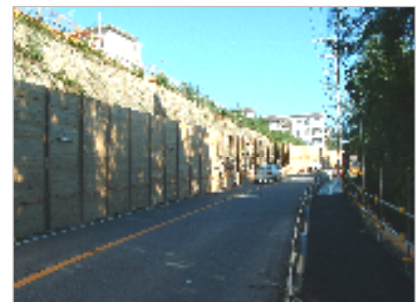
工事区間仮設状況
